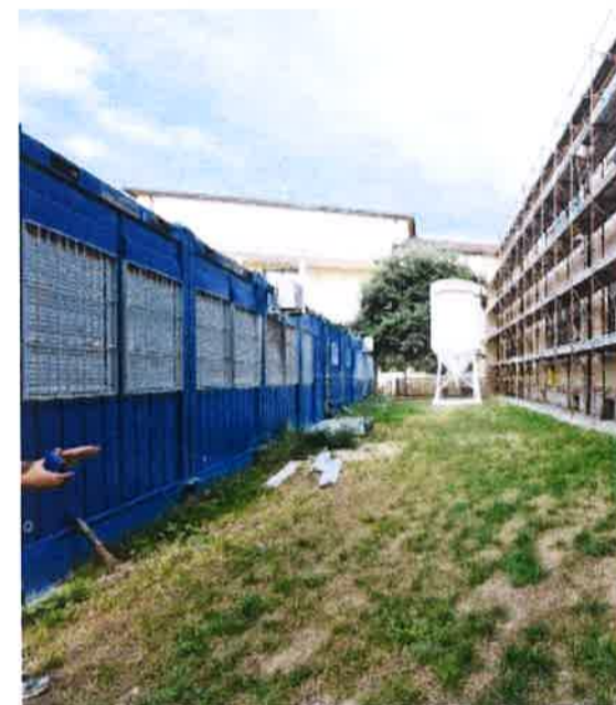
San Bonifacio Il cantiere nell'ala nord delle Sandri, a sinistra i moduli DIENNE
